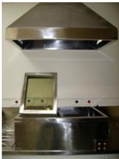
Figura 03 – Exaustor bancada de manipulação.
