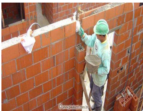
Figura 2 – Assentamento de blocos de alvenaria estrutural – Disponível em http://www.pauluzzi.com.br/alvenaria.php?PHPSESSID=b33e8455726b2f2fd00d57065dcac71f7
