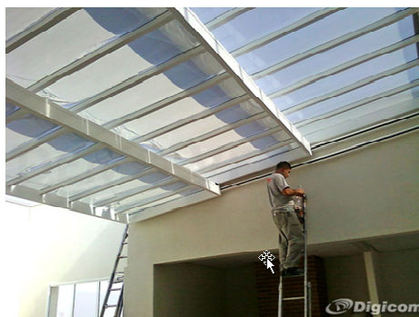
Figura 1: Cobertura em policarbonato.
