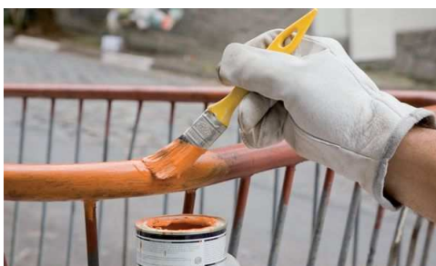
Figura 1 – Pintura com esmalte sintético. Disponível em http://equipedeobra.pini.com.br/construcao-reforma/64/como-calculas-quantidade-de-
