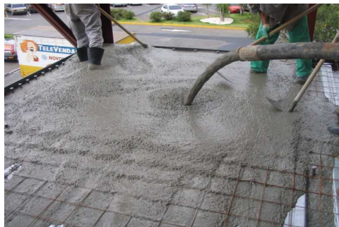
Figura 1 – Lançamento do concreto. Disponível em http://construcaocivilpet.wordpress.com/2012/11/07/o-concreto-como-material-construtivo-da-origem-as-novas-tecnologias/
