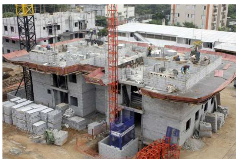
Figura 1 – Construção em alvenaria estrutural. Disponível em http://www.cimentoitambe.com.br/alvenaria-estrutural-saiba-como-evitar-patologias/
