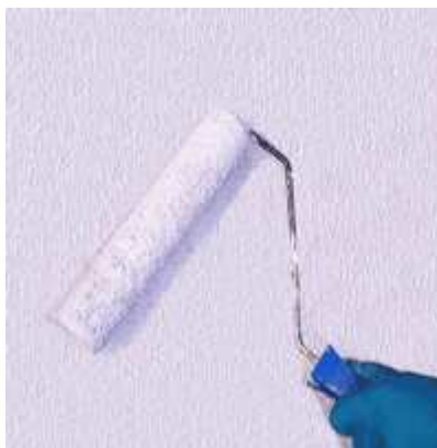
Figura 1 – Pintura de parede com rolo.
