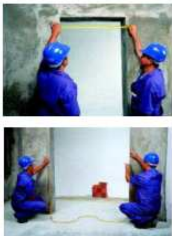
Figura 1 – Verificação de alinhamento e nível para assentamento de contramarcos. Disponível em http://professor.ucg.br/
