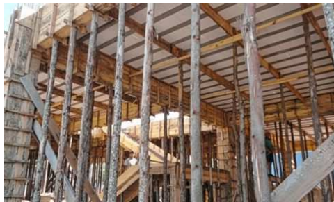
Figura 1 – Escoramento de laje. Disponível em http://www.odiarario.com/construir-e-decorar/noticia/586869/escoras-definem-estrutura-da-obra/
