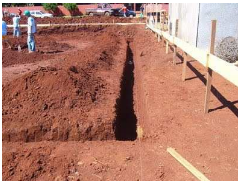
Figura 1 – Locação de obra – Disponível em http://www.edificacoesjf.blogspot.com.br/2010/04/locacao-de-obras.html
