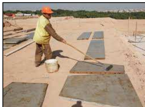
Figura 2 - Limpeza das formas. Disponível em http://www.solucoesparacidades.com.br
