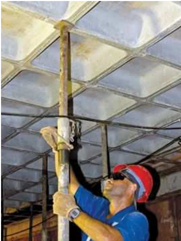
Figura 1 – Retirada de escoramento metálico. Disponível em http://equipedeobra.pini.com.br/construcao-reforma/52/escoramentos-metalicos-quantidade-de-pecas-varia-conforme-as-caracteristicas-2694
