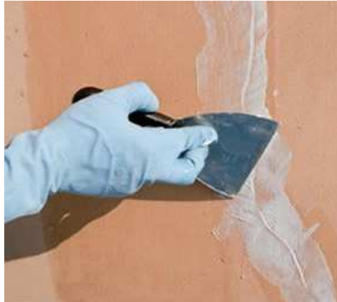
Figura 1 – Emassamento de trinca com massa corrida. Disponível em http://equipedeobra.pini.com.br/construcao-reforma/47/artigo257605-1.aspx
