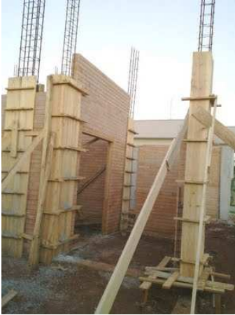
Figura 1 – Formas de pilares posicionadas. Disponível em http://www.ecooca.org/construo-sustentvel/obra
