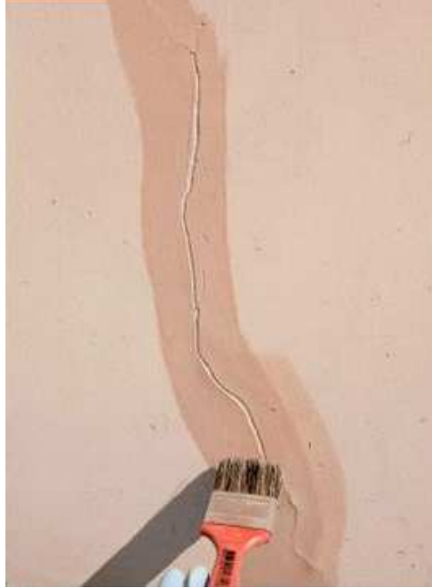
Figura 1 – Aplicação de fundo selador. Disponível em
