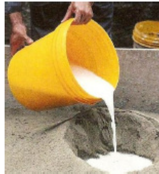
Figura 1 – Aditivo impermeabilizante adicionado à argamassa. Disponível em http://w3.ufsm.br/ppgec/wp-content/uploads/Geovane_Venturini_Righi_Disserta%C3%A7%C3%A3o_de_Mestrado.pdf
