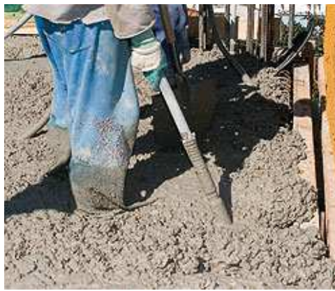
Figura 1 – Adensamento com vibrador de imersão. Disponível em
