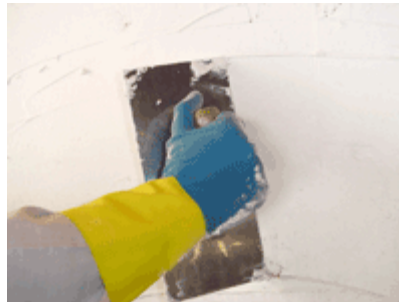
Figura 1 – Aplicação de massa acrílica niveladora.
