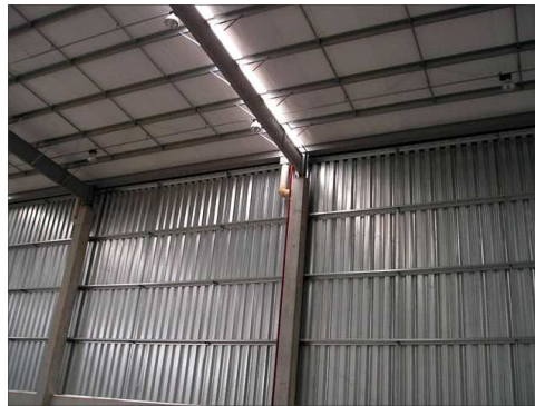
Figura 1 – Fechamento em telha de aço.
