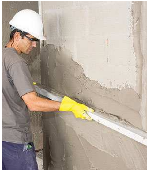
Figura 1 – Sarrafeamento de massa paulista. Disponível em http://www.pedreiro.com.br/geral/alvenarias-e-reboco/reboco-de-parede-passo-a-passo/
