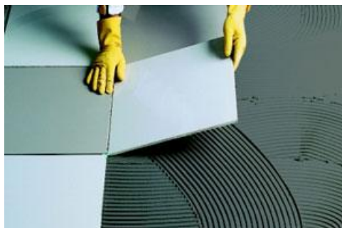
Figura 1 – Assentamento de piso cerâmico.
