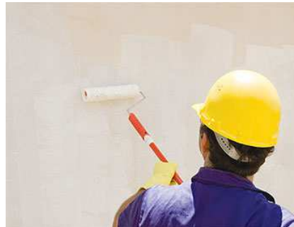
Figura 1 – Pintura de parede. Disponível em http://www.mundoindica.com.br/como-pintar-paredes-internas-passo-a-passo
