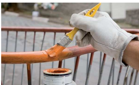
Figura 1 – Pintura com esmalte sintético. Disponível em http://equipedeobra.pini.com.br/construcao-reforma/64/como-calcular-quantidade-de-
