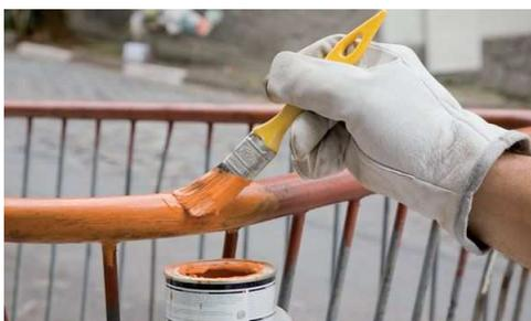
Figura 1 – Pintura com esmalte sintético. Disponível em <http://equipedeobra.pini.com.br/construcao-reforma/64/como-calculer-quantidade-de->
