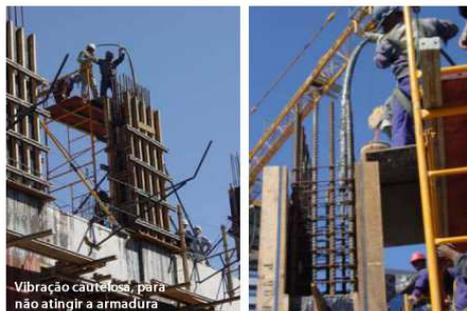
Figura 2 – Lançamento de concreto em pilares. Disponível em <http://www.comunidadeconstrucao.com.br/sistemas-construtivos/3/concretagem-praticas/execucao/60/concretagem-praticas.html>
