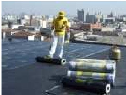
Figura 1 – Impermeabilização com manta asfáltica. Disponível em <http://www.casadoimpermeabilizante.com.br/problemas-e-solucoes>
