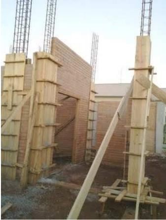
Figura 1 – Formas de pilares posicionadas.
