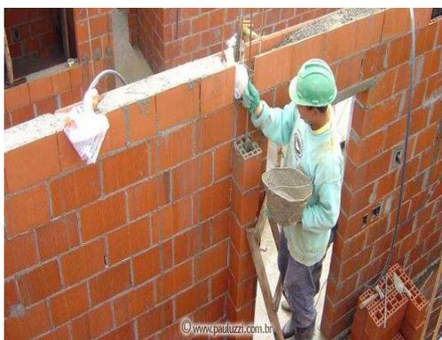
Figura 2 – Assentamento de blocos de alvenaria estrutural – Disponível em
