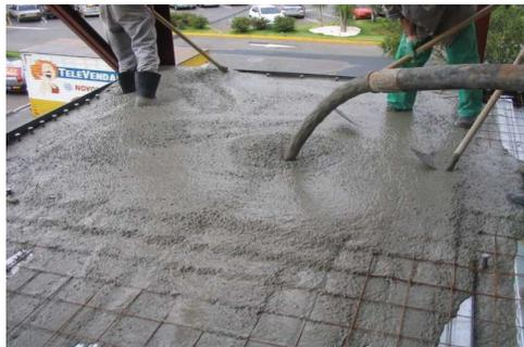
Figura 1 – Lançamento do concreto. Disponível em <http://construcaocivilpet.wordpress.com/2012/11/07/o-concreto-como-material-construtivo-da-origem-as-novas-tecnologias/>
