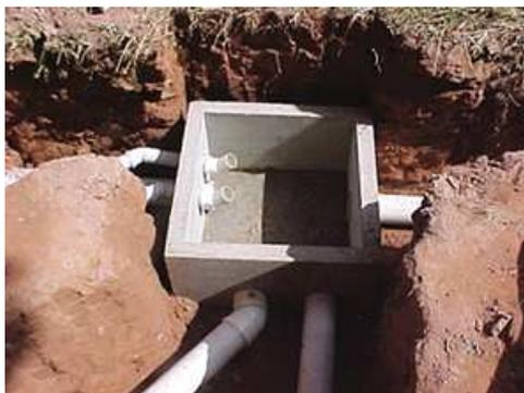
Figura 1 – Caixa de inspeção. Disponível em <http://piniweb.pini.com.br/construcao/noticias/como-executar-caixas-de-inspecao-80301-1.aspx>
