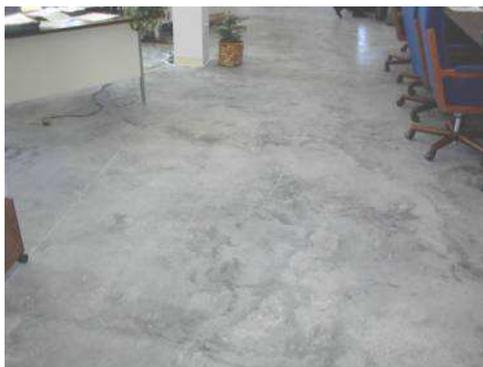
Figura 1 - Piso cimentado queimado. Disponível em <http://mundotop.com/cimento-queimado-revestimento-de-pisos/>
