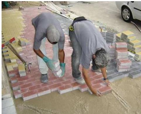
Figura 1 – Assentamento de piso intertravado.
