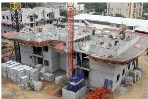
Figura 1 – Construção em alvenaria estrutural.
