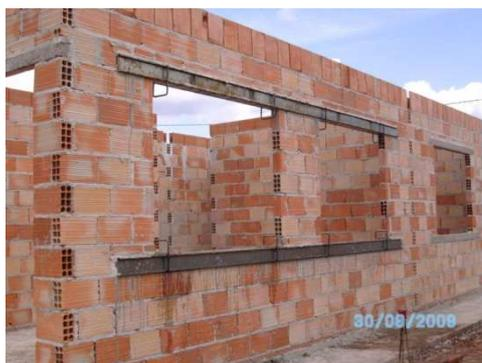
Figura 1 – Posicionamento de verga e contraverga em alvenaria. Disponível em <http://andriecardo.deviantart.com/art/forma-verga-contra-verga-142283653>
