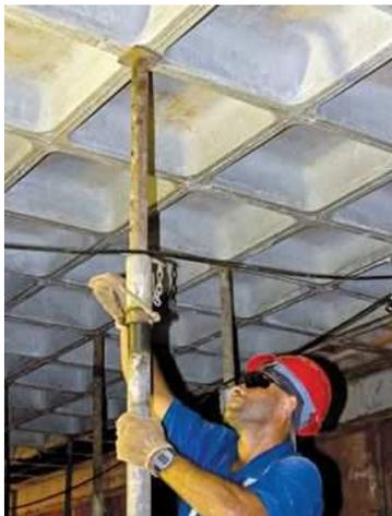
Figura 1 – Retirada de escoramento metálico.
