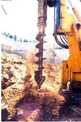
Figura 1 – Escavação de estaca. Disponível em <http://www.basestrauss.com.br/escavada.html>
