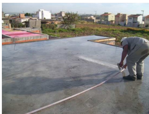
Figura 2 – Cura de laje de concreto. Disponível em http://www.pedreiroao.com.br/geral/a-cura-do-concreto-passo-a-passo/
