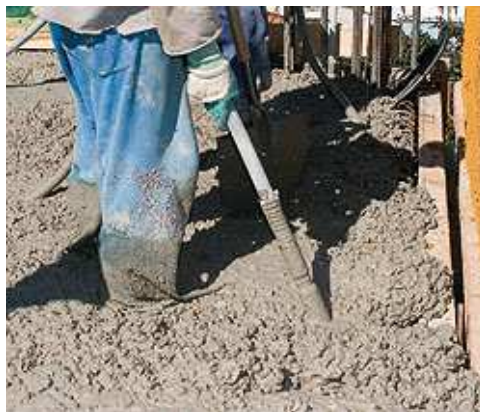
Figura 1 – Adensamento com vibrador de imersão. Disponível em http://equipedeobra.pini.com.br/construcao-reforma/43/artigo243513-1.aspx
