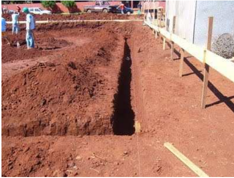
Figura 1 – Locação de obra.
