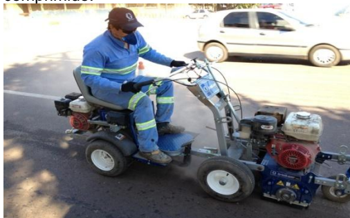
Figura 1 - Remoção de Sinalização Horizontal. Disponível
