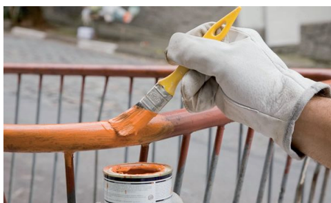
Figura 1 – Pintura com esmalte sintético. Disponível em http://equipedeobra.pini.com.br/construcao-reforma/64/como-calcular-quantidade-de-
