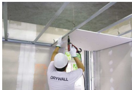
Figura 1 – Instalação de forro de gesso acartonado. Disponível em http://www.cliquearquitectura.com.br/portal/dicas/view/gesso-acartonado-resistencia-mecanica/140
