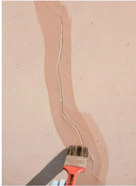
Figura 1 – Aplicação de fundo selador. Disponível em
