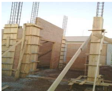
Figura 1 – Formas de pilares posicionadas. Disponível em http://www.ecooca.org/construo-sustentvel/obra
