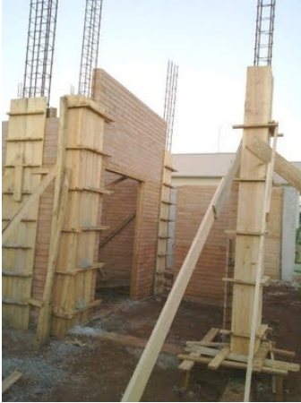
Figura 1 – Formas de pilares posicionadas. Disponível em http://www.ecooca.org/construo-sustentvel/obra
