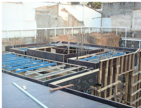
Figura 1 – Formas de vigas e lajes. Disponível em http://www.lix.com.br/obras-fotos.aspx?idEtapa=1639
