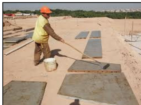
Figura 2 - Limpeza das formas. Disponível em http://www.solucoesparacidades.com.br
