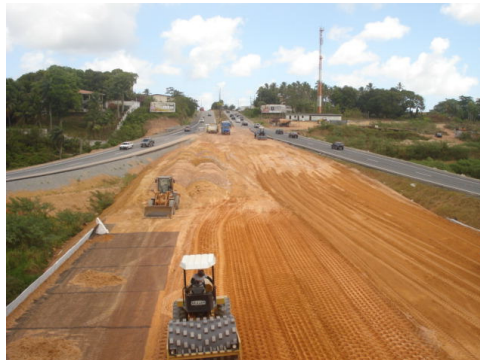
Figura 1 – Execução de compactação de aterro. Disponível em http://www.terraplenagem.net/dicionario/a/aterro/
