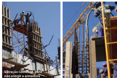
Figura 2 – Lançamento de concreto em pilares. Disponível em
