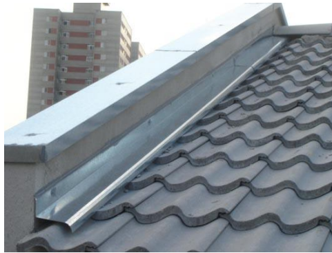
Figura 1 - Rufo instalado. Disponível em http://www.engenhariacivil.com/dicionario/rufo
