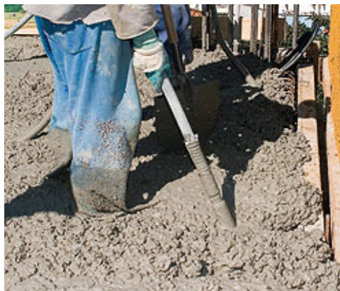
Figura 1 – Adensamento com vibrador de imersão. Disponível em
