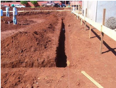
Figura 1 – Locação de obra.
