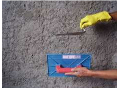
Figura 1 – Lançamento de massa para chapisco. Disponível em http://www.pedreiro.com.br/geral/alvenarias-e-reboco/como-executar-chapisco-passo-a-passo/
