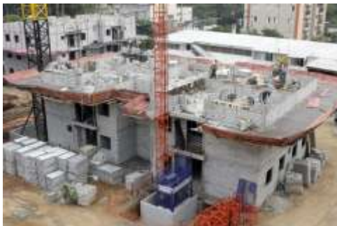
Figura 1 – Construção em alvenaria estrutural. Disponível em http://www.cimentoitambe.com.br/alvenaria-estrutural-saiba-como-evitar-patologias/
