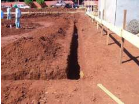
Figura 1 – Locação de obra.
