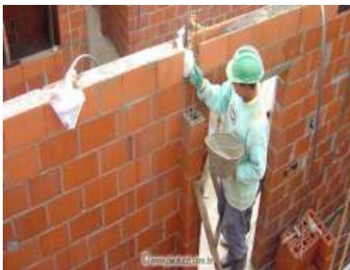
Figura 2 – Assentamento de blocos de alvenaria estrutural – Disponível em http://www.pauluzzi.com.br/alvenaria.php?PHPSESSID=b33e8455726b2ffd00d57065dcac71f7
