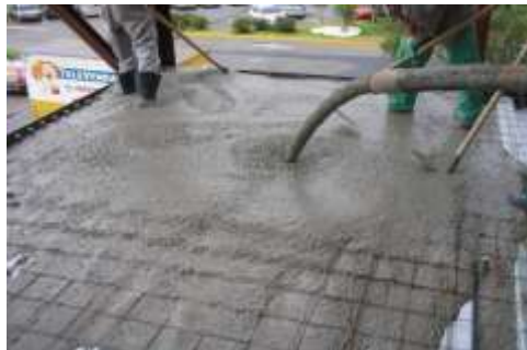
Figura 1 – Lançamento do concreto. Disponível em http://construcaocivilpet.wordpress.com/2012/11/07/o-concreto-como-material-constutivo-da-origem-as-novas-tecnologias/
