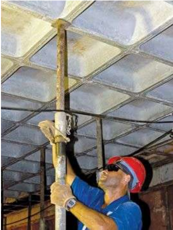
Figura 1 – Retirada de escoramento metálico. Disponível em http://equipedeobra.pini.com.br/construcao-reforma/52/escoramentos-metalicos-quantidade-de-pecas-varia-conforme-as-caracteristicas-2694
