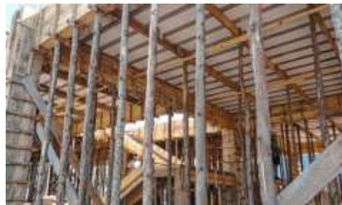
Figura 1 – Escoramento de laje. Disponível em http://www.odiarior.com/construir-e-decorar/noticia/586869/escoras-definem-estrutura-da-obra/
