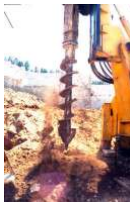
Figura 1 – Escavação de estaca. Disponível em http://www.basestrauss.com.br/escavada.html
