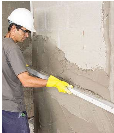
Figura 1 – Sarrafeamento de massa paulista. Disponível em http://www.pedreiro.com.br/geral/alvenarias-e-reboco/reboco-de-parede-passo-a-passo/
