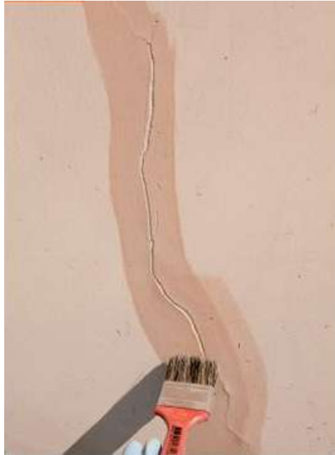
Figura 1 – Aplicação de fundo selador. Disponível em
