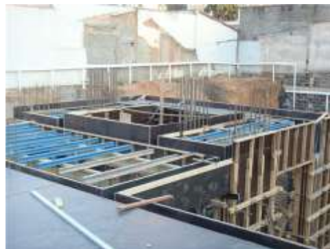
Figura 1 – Formas de vigas e lajes. Disponível em http://www.lix.com.br/obras-fotos.aspx?idEtapa=1639
