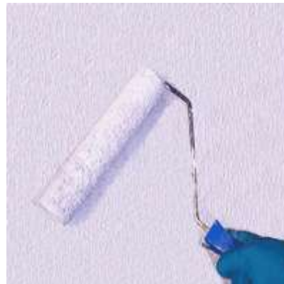
Figura 1 – Pintura de parede com rolo.
