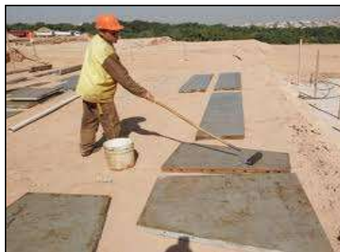
Figura 2 - Limpeza das formas. Disponível em http://www.solucoesparacidades.com.br
