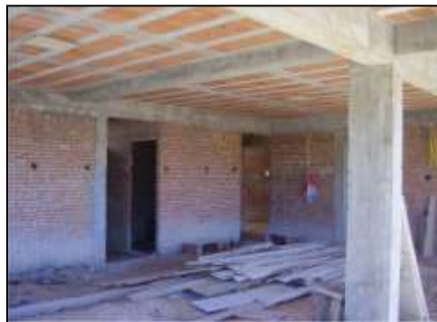
Figura 1 – Retirada de formas de estrutura. Disponível em http://www.construtorasgm.com.br
