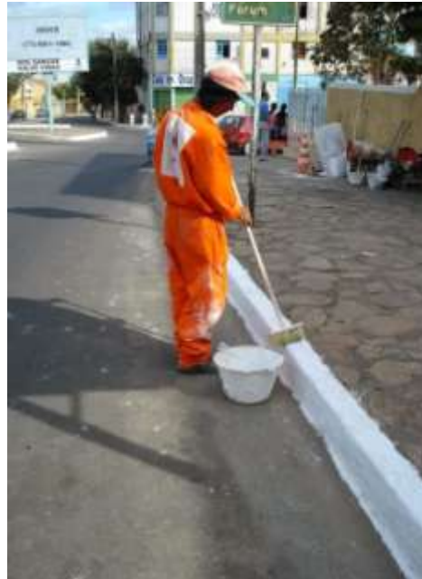
Figura 1 – Caiação de meio-fio: http://www.blogdobsilva.com.br/2014/01/voce-prefere-ou-nao-o-meio-fio-pintado.html
