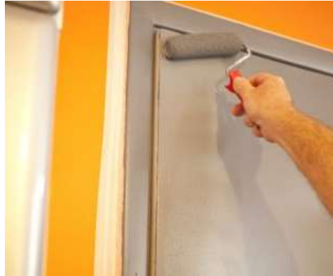
Figura 1 – Pintura esmalte a base de água. Disponível em http://mulher.uol.com.br/casa-e-decoracao/album/pintura_porta_fabianocerchiar_album.htm#fotoNav=17
