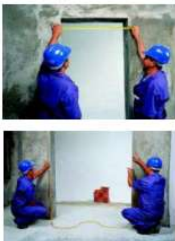
Figura 1 – Verificação de alinhamento e nível para assentamento de contramarcos. Disponível em http://professor.ucg.br/
