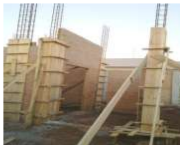
Figura 1 – Formas de pilares posicionadas. Disponível em http://www.ecooca.org/construo-sustentvel/obra
