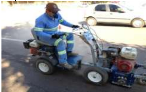
Figura 1 - Remoção de Sinalização Horizontal. Disponível
