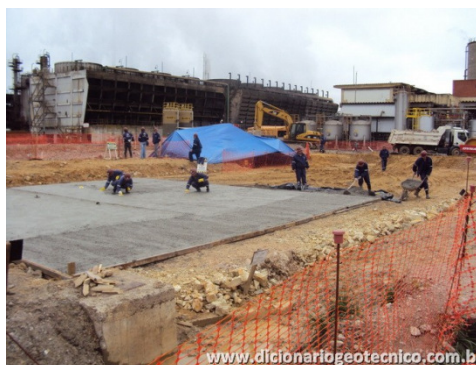
Figura 1 – Construção de radier. Disponível em http://www.dicionariogeotecnico.com.br/album/fundacoes/radier/pages/image/imagepage1.html
