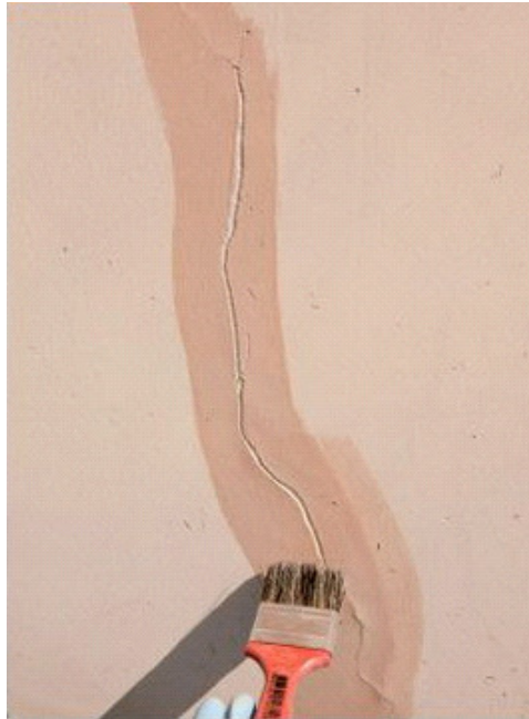
Figura 1 – Aplicação de fundo selador. Disponível em
