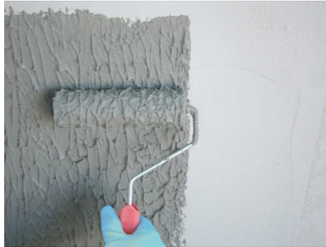
Figura 1 – Pintura texturizada aplicada com rolo. Disponível em http://londrinatintas.com.br/?p=1041
