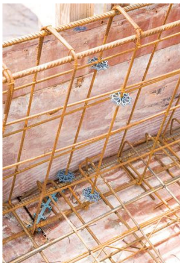
Figura 1 – Armadura posicionada para processo de concretagem. Disponível em http://equipedeobra.pini.com.br/construcao-reforma/45/cobrimento-de-armaduras-espessura-de-camada-de-concreto-sobre-250451-1.aspx
