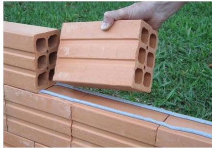
Figura 1 – Assentamento de blocos cerâmicos furados. Disponível em http://www.cecorienta.com.br
