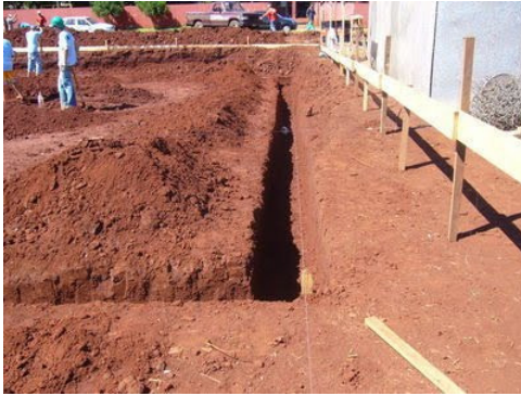
Figura 1 – Locação de obra.
