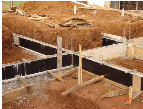
Figura 1 – Execução de viga baldrame. Disponível em
