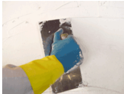
Figura 1 – Aplicação de massa acrílica niveladora.
