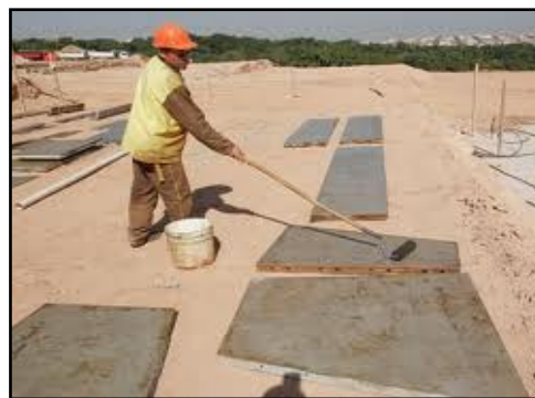
Figura 2 - Limpeza das formas. Disponível em http://www.solucoesparacidades.com.br
