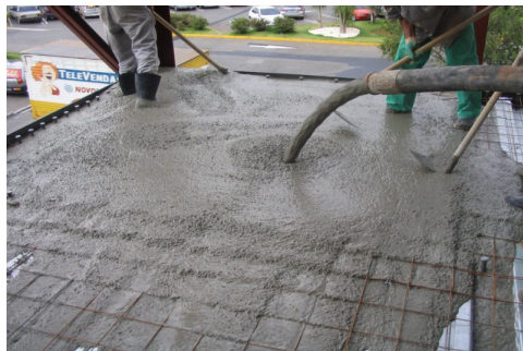
Figura 1 – Lançamento do concreto. Disponível em http://construcaocivilpet.wordpress.com/2012/11/07/o-concreto-como-material-constutivo-da-origem-as-novas-tecnologias/
