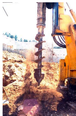
Figura 1 – Escavação de estaca. Disponível em http://www.basestrauss.com.br/escavada.html
