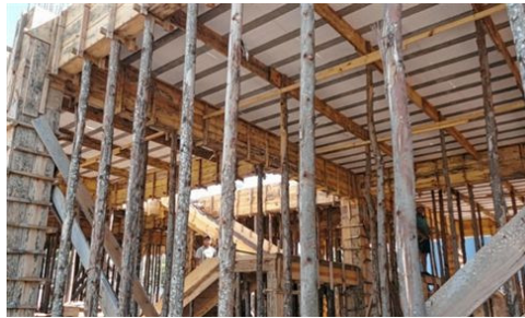
Figura 1 – Escoramento de laje. Disponível em http://www.odiario.com/construir-e-decorar/noticia/586869/escoras-definem-estrutura-da-obra/
