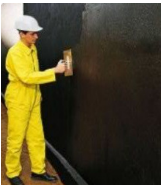
Figura 1 – Aplicação de impermeabilização com pintura betuminosa. Disponível em
