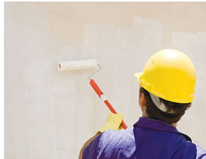
Figura 1 – Pintura de parede. Disponível em http://www.mundoindica.com.br/como-pintar-paredes-internas-passo-a-passo
