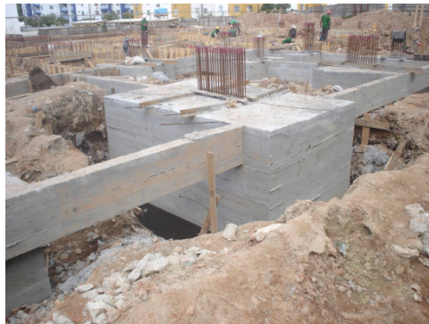
Figura 1 – Bloco de coroamento. Disponível em https://sites.google.com/site/fundacoesecv5135081/3.jpg
