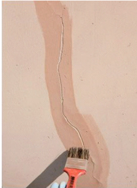
Figura 1 – Aplicação de fundo selador. Disponível em
