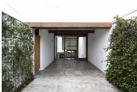
Figura 1 – Piso cimentado desempenado. Disponível em http://mulher.uol.com.br/casa-e-decoracao/album/guilherme_mendes_darocha_reformacao_franparente_album.htm#fotoNav=29
