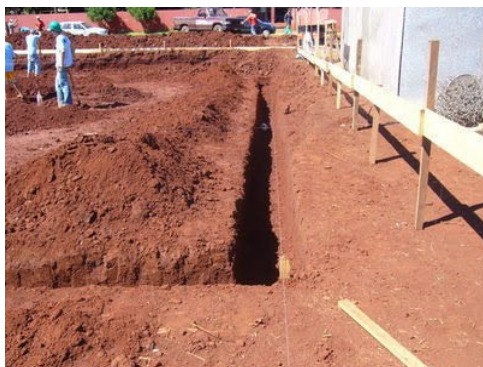
Figura 1 – Locação de obra – Disponível em http://www.edificacoesjf.blogspot.com.br/2010/04/locacao-de-obras.html
