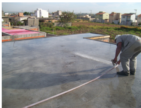
Figura 2 – Cura de laje de concreto. Disponível em http://www.pedreiro.com.br/geral/a-cura-do-concreto-passo-a-passo/
