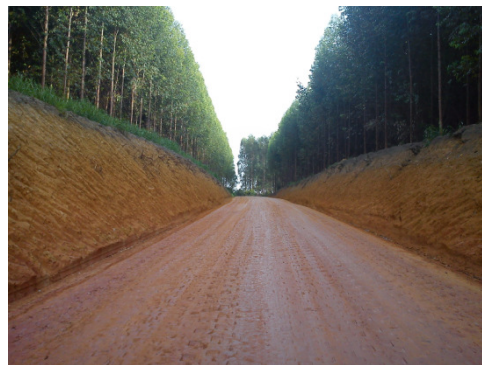
Figura 1 – Vista de corte executado em encosta. Disponível em http://engecr.am.com.br/areas-de-atuacao/obras-rodoviaras/
