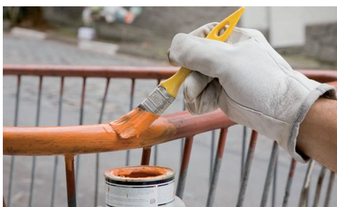
Figura 1 – Pintura com esmalte sintético. Disponível em http://equipedeobra.pini.com.br/construcao-reforma/64/como-calcular-quantidade-de-
