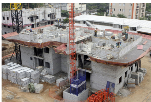
Figura 1 – Construção em alvenaria estrutural. Disponível em http://www.cimentoitambe.com.br/alvenaria-estrutural-saiba-como-evitar-patologias/
