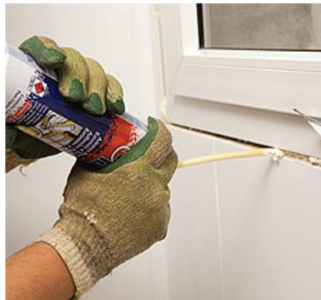
Figura 2 – Fixação de esquadria. Disponível em <http://techne.pini.com.br/>
