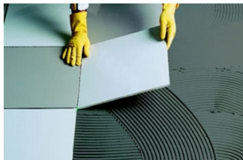
Figura 1 – Assentamento de piso cerâmico.
