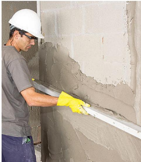
Figura 1 – Sarrafeamento de massa paulista. Disponível em <http://www.pedreiro.com.br/geral/alvenarias-e-reboco/reboco-de-parede-passo-a-passo/>
