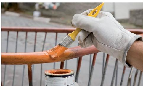
Figura 1 – Pintura com esmalte sintético. Disponível em <http://equipedeobra.pini.com.br/construcao-reforma/64/como-calcular-quantidade-de->
