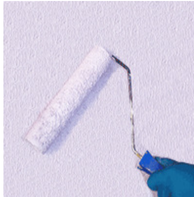
Figura 1 – Pintura de parede com rolo.
