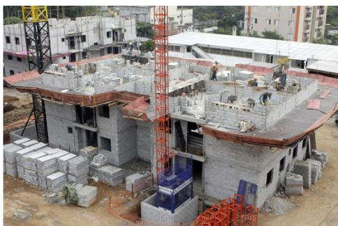
Figura 1 – Construção em alvenaria estrutural.
