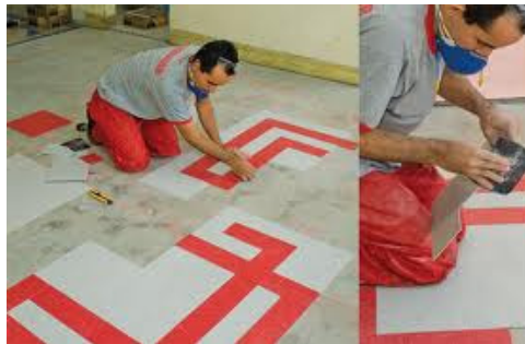
Figura 1 – colocação de piso em placa vinílica. Disponível em http://soprodearquite.com.br/como-colocar-pisos-vinilicos-utilizando-soprador-de-ar-quente/
