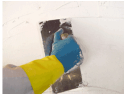
Figura 1 – Aplicação de massa acrílica niveladora.
