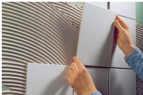
Figura 1 – Assentamento de revestimento cerâmico em parede. Disponível em http://www.opopular.lugarcerto.com.br/
