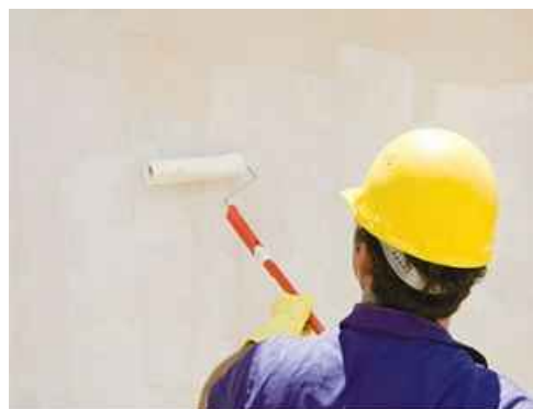
Figura 1 – Pintura de parede. Disponível em: http://www.mundoindica.com.br/como-pintar-paredesinternas-passo-a-passo
