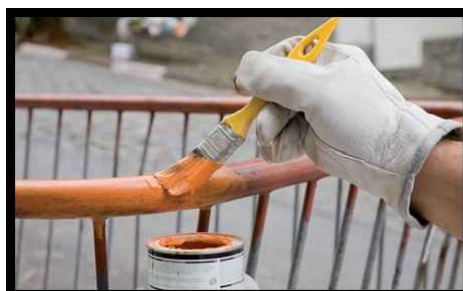
Figura 1 - Pintura com esmalte sintético. Disponível em http://equipedeobra.pini.com.br/construcao-reforma/64/como-calcular-quantidade-de-materiais-para-pintura-de-grades--297870-1.aspx
