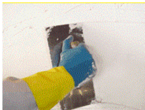
Figura 1 - Aplicação de massa acrílica niveladora. Disponível em http://www.monterey.com.br/?categoria=massas&sub=niveladora
