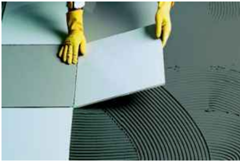
Figura 1 - Assentamento de piso cerâmico. Disponível em http://imoveis.culturamix.com/construcao/como-assentar-ceramica
