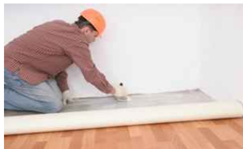
Figura 1 – Colocação de piso vinílico em rolo. Disponível em: http://vamosconstruir.com/acabamento/piso-vinilico
