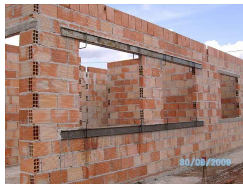
Figura 1 - Posicionamento de verga e contra-verga em alvenaria. Disponível em http://andrerichardo.deviantart.com/art/forma-verga-contra-verga-142283653
