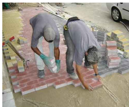
Figura 1 - Assentamento de piso intertravado. Disponível em http://concretorj.blogspot.com.br/2012/11/execucao-do-piso-intertravado.html
