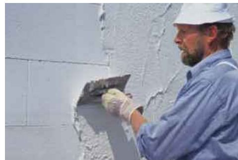
Figura 1 - aplicação de gesso sobre parede de alvenaria. Disponível em http://revista.penseimoveis.com.br/especial/rs/editorial-imoveis/19,480,2908879,Gesso-para-toda-obra.html
