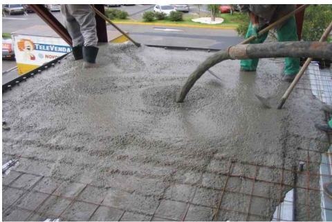
Figura 1 - Lançamento do concreto. Disponível em http://construcaocivilpet.wordpress.com/2012/11/07/o-concreto-como-material-construtivo-da-origem-as-novas-tecnologias/
