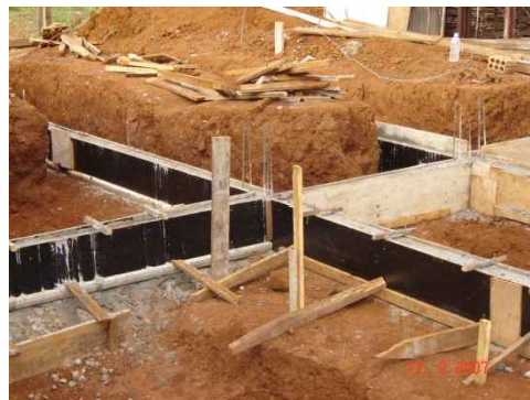
Figura 1 - Execução de viga baldrame. Disponível em http://www.ebah.com.br/content/ABAAABuJ8AH/trabalho-pronto-baldrames
