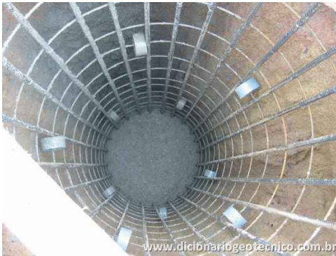
Figura 1 - Tubulão a céu aberto em concretagem. Disponível em http://www.dicionariogeotecnico.com.br/album/fundacoes/tubulaoca/pages/image/imagepage31.html
