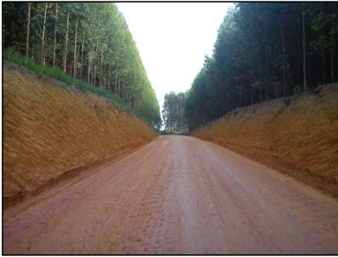
Figura 1 - Vista de corte executado em encosta. Disponível em http://engecram.com.br/areas-de-atuacao/obras-rodoviaras/
