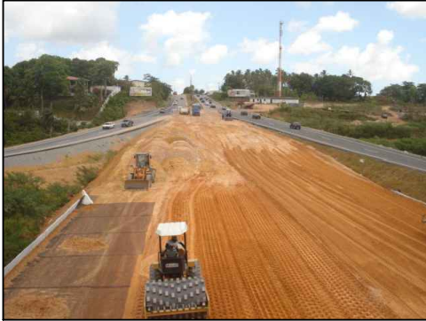
Figura 1 - Execução de compactação de aterro. Disponível em: http://www.terraplenagem.net/dicionario/a/at
