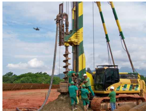
Figura 1 - Escavação de hélice monitorada contínua. Disponível em http://www.nacionalfundacoes.com.br/fotos-da-estaca-helice-continua.php
