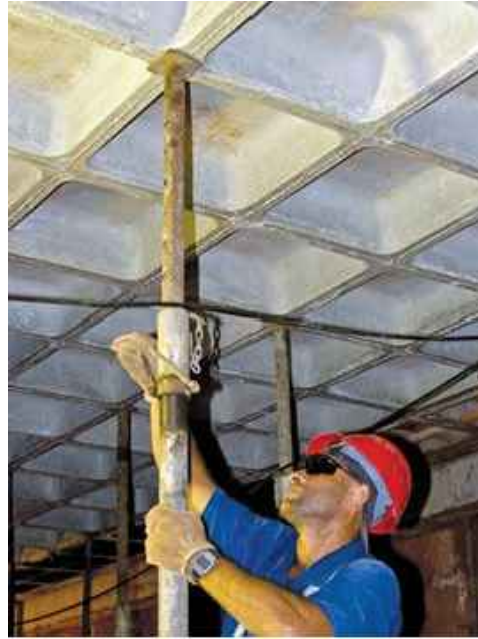
Figura 1 - Retirada de escoramento metálico. Disponível em http://equipedeobra.pini.com.br/construcao-reforma/52/escoramentos-metalicos-quantidade-de-pecas-varia-conforme-as-caracteristicas-2694
