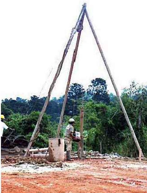
Figura 1 - Execução de estaca Strauss. Disponível em http://www.basestrauss.com.br/strauss.html
