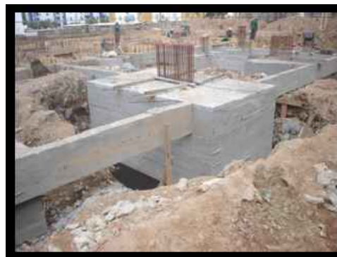
Figura 1 - Bloco de coroamento. Disponível em https://sites.google.com/site/fundacoescv5135081/3.jpg
