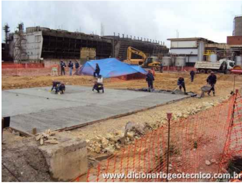
Figura 1 - Construção de radier. Disponível em http://www.dicionariogeotecnico.com.br/album/fundacoes/radier/pages/image/imagepage1.html
