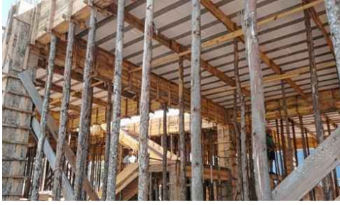
Figura 1 - Escoramento de laje. Disponível em http://www.odiarario.com/construir-e-decorar/noticia/586869/escoras-definem-estrutura-da-obra/
