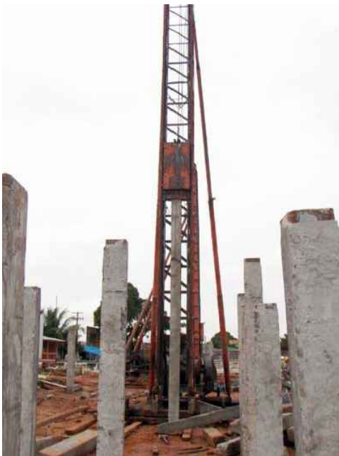
Figura 1 - Cravação de estaca pré-moldada de concreto. Disponível em http://www.norcicolfundacoes.com.br/cravacoes_estacas.php
