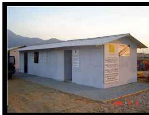
Figura 1 - Exemplo de instalação provisória de canteiro de obras. Disponível em http://www.sulbrasil.eng.br/hp/planejamento/implantacao.php
