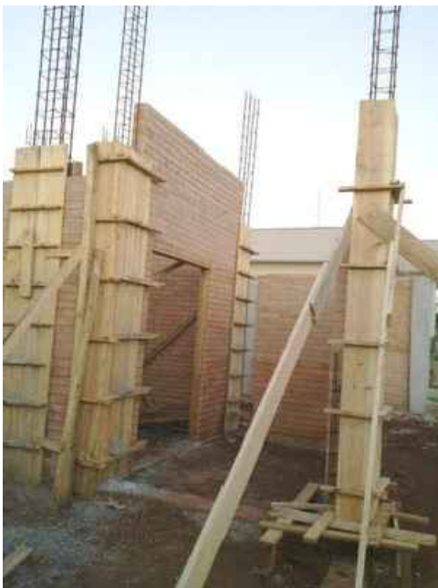
Figura 1 - Formas de pilares posicionadas. Disponível em http://www.ecooca.org/construo-sustentvel/obra
