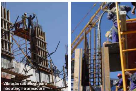
Figura 2 - Lançamento de concreto em pilares. Disponível em http://www.comunidade-da-construcao.com.br/sistemas-construtivos/3/concretagem-praticas/execucao/60/concretagem-praticas.html
