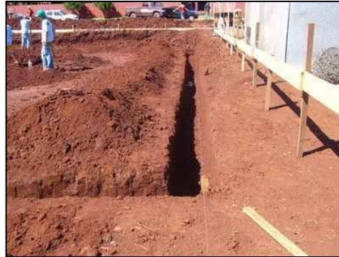
Figura 1 - Locação de obra - Disponível em
