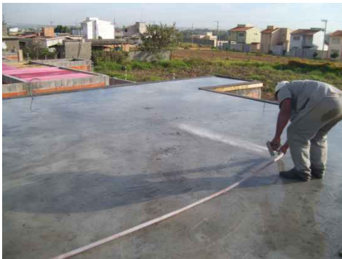
Figura 2 - Cura de laje de concreto. Disponível em http://www.pedreiro.com.br/geral/a-cura-do-concreto-passo-a-passo/
