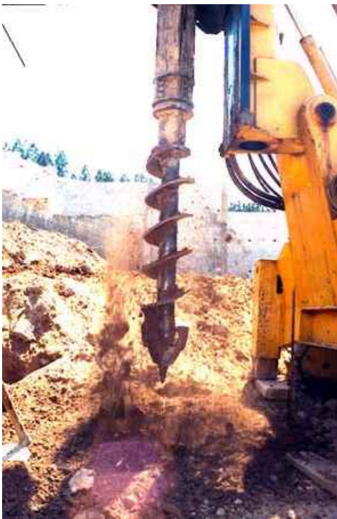
Figura 1 - Escavação de estaca. Disponível em http://www.basestrauss.com.br/escavada.html
