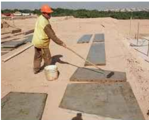
Figura 2 - Limpeza das formas. Disponível em http://www.solucoesparacidades.com.br
