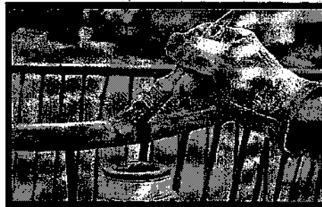
Figura 1 - Pintura com esmalte sintético. Disponível em http://equipedeobra.pini.com.br/construcao-reforma/64/como-calcular-quantidade-de-materiais-para-pintura-de-grades--297870-1.aspx
