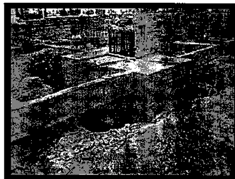
Figura 1 - Bloco de coroamento. Disponível em https://sites.google.com/site/fundacoesecv5135081/3.jpg
