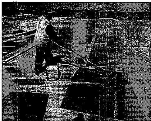
Figura 2 - Limpeza das formas. Disponível em http://www.solucoesparacidades.com.br
