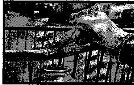
Figura 1 - Pintura com esmalte sintético. Disponível em http://equipedeobra.pini.com.br/construcao-reforma/64/como-calcular-quantidade-de-materiais-para-pintura-de-grades--297870-1.aspx
